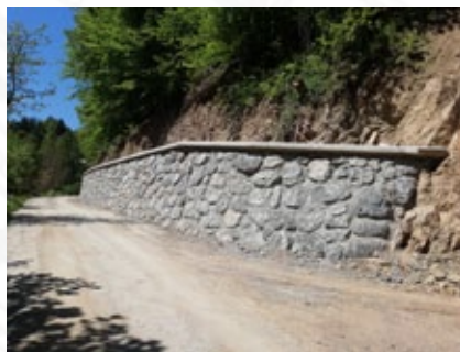
Izveden oporni zid v dolžini okoli 84 m
