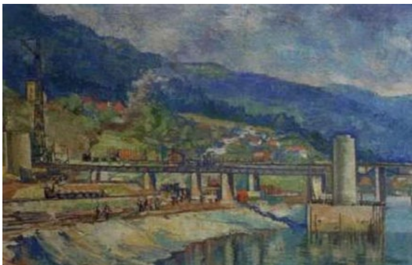
Gradnja nadomestnega železniškega mostu za elektrarno, 1942.
