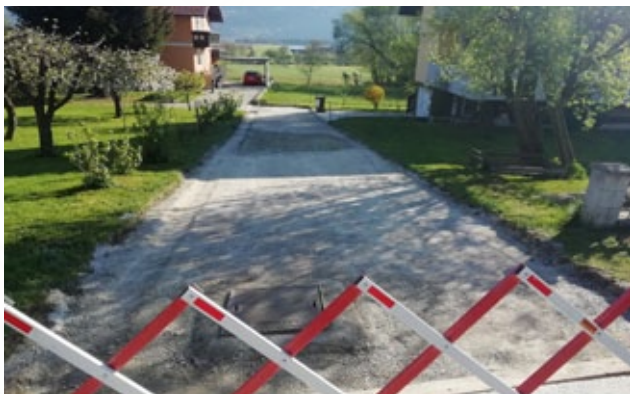
Pripravljeno za asfaltažo
