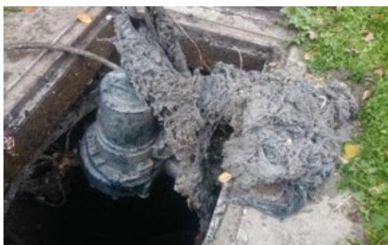
Novi primeri zamašitev črpalk in jaškov na črpališčih Jedert in Dravograd
