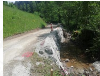
Podporni zid – kamnita obloga ob potoku
