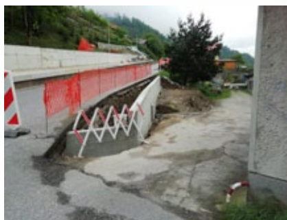
Podporni zid pri garažah
