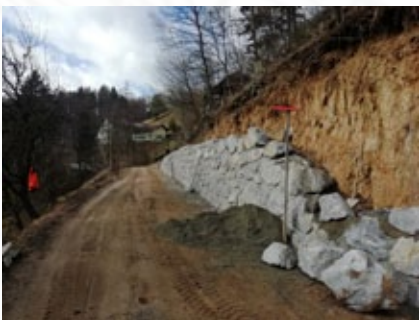
Gradnja opornega zidu
