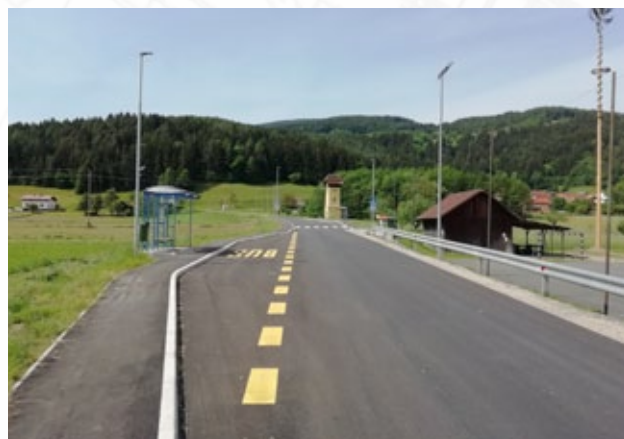
Nova pešpot z avtobusnima postajališčema, javno razsvetljavo in obnovljeno državno cesto
