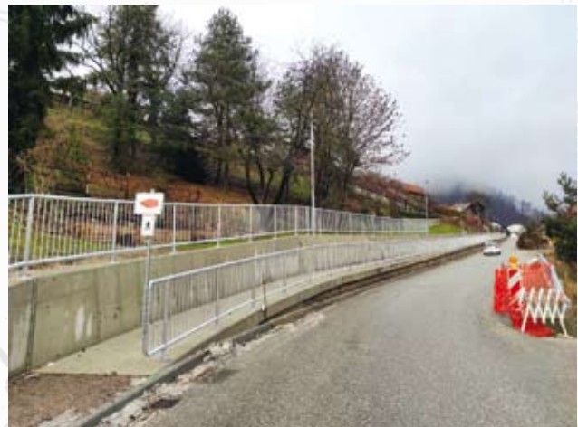
Že zgrajen del pešpoti v smeri proti Robindvoru
