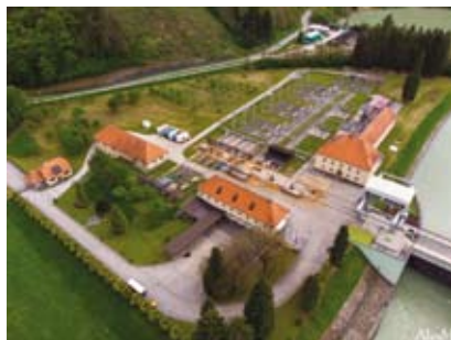
Elektrarniške zgradbe so bile dokončno obnovljene v letih po vojni, elektrarna pa je polno zaživela leta 1955. (foto: Aleš Mlačnik)
