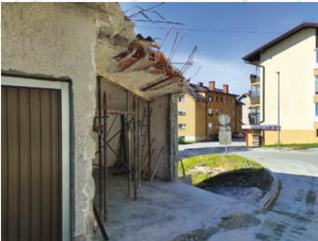
Odstranjevanje dela garaže za ureditev dovozne poti
