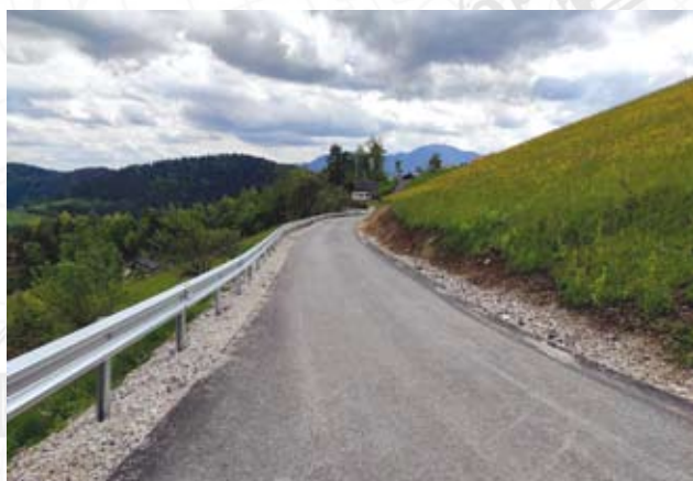
Nameščena varovalna ograja pod p. d. Posratom
