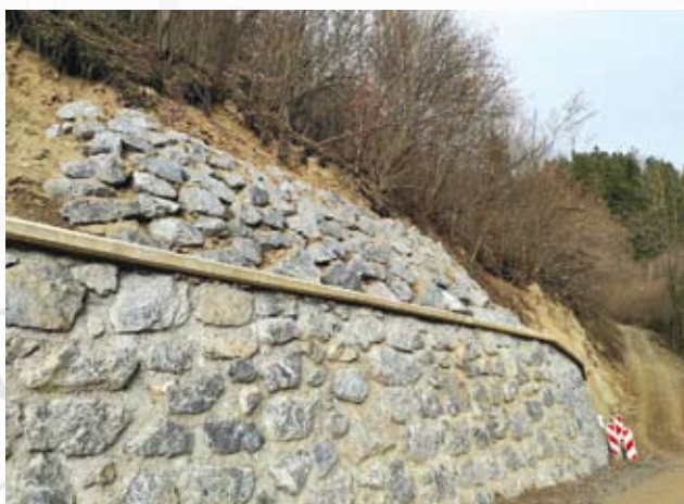
Suha kamnita zložba nad podpornim zidom
