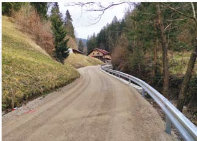
Pripravljena tamponska podlaga za asfaltiranje
